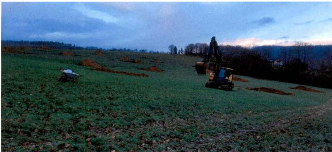
Abbildung 1: Baufeld, Blick nach Osten
