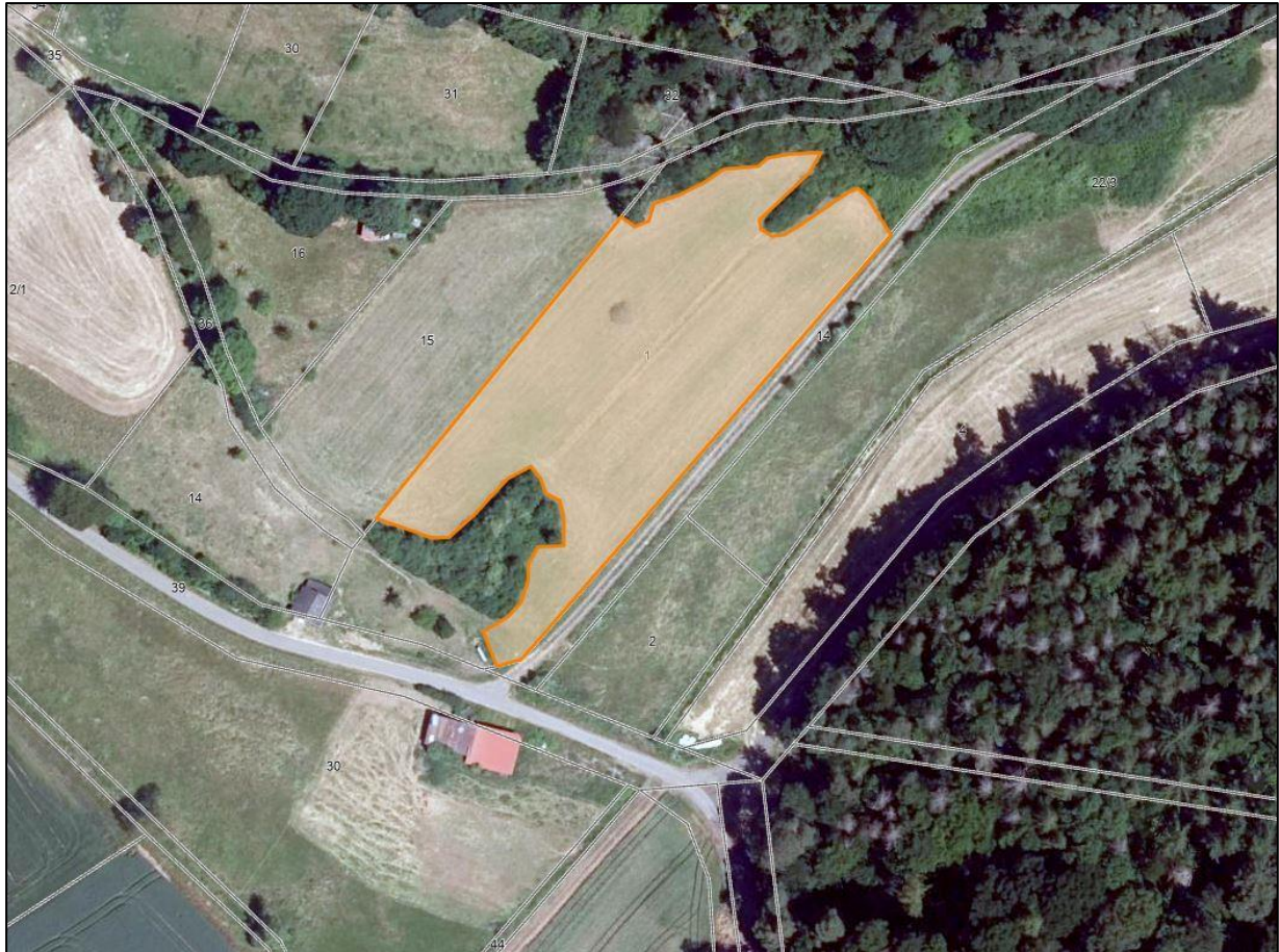
Abb. 18: Lage der externen Ausgleichsfläche 2 in Königshagen, Gemeinde Edertal, Flur 14, Flurstücke 1 (orangene Umrandung) Quelle: Natureg, genordet, ohne Maßstab
